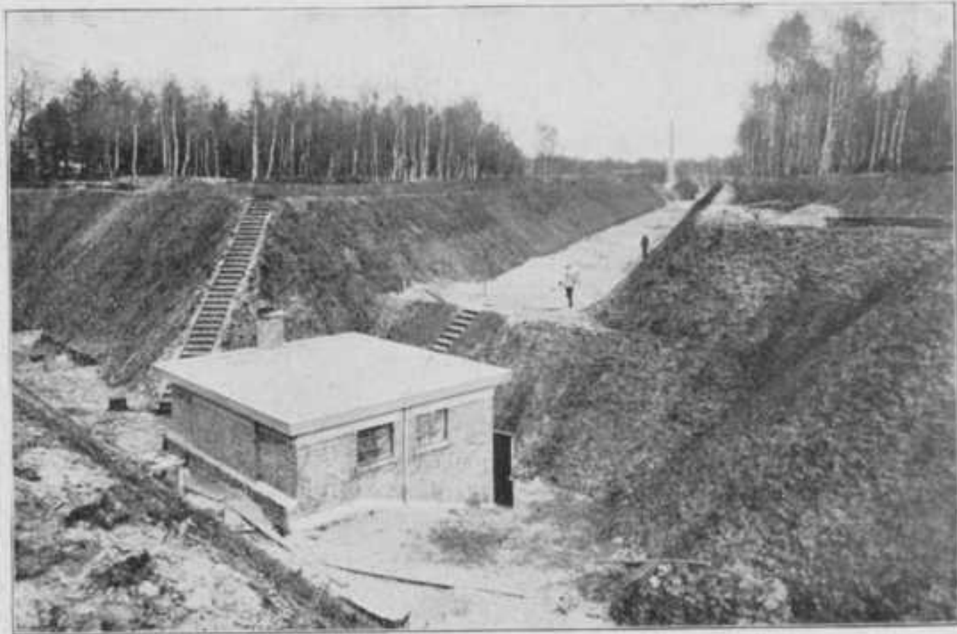
Salle des pompes centrifuges de Laren 1929
