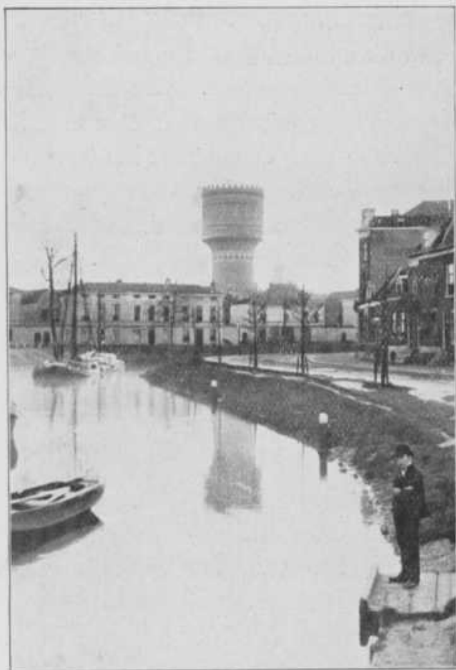
Château d'eau au Predikheerenkerkhof Utrecht 1896.
